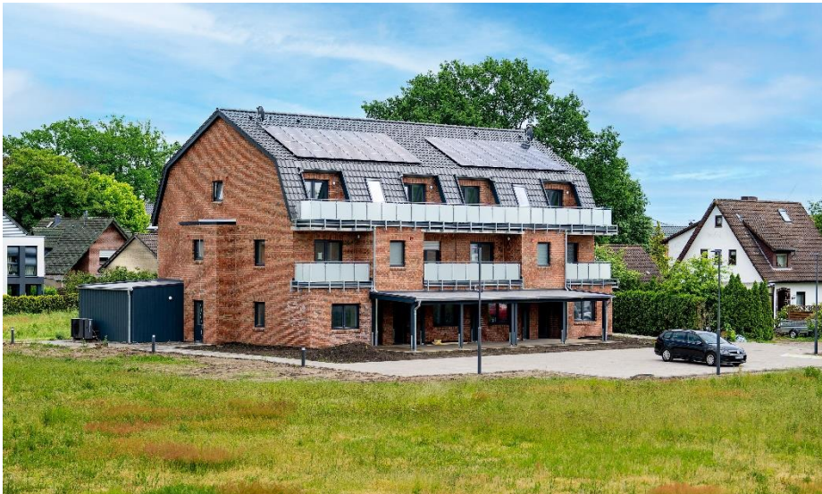
Das neue Stadthaus im Mittelweg, Langwedel, der Stiftung Waldheim wenige Wochen vor Fertigstellung. Foto: Stiftung Waldheim
